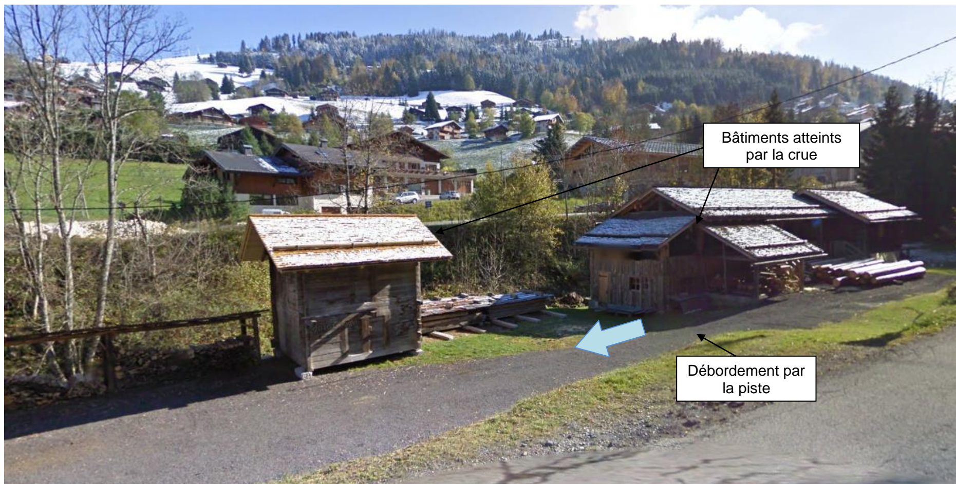
Débordement de la crue en rive gauche par la piste d'accès aux bâtiments de stockage (source : Google Street View)
