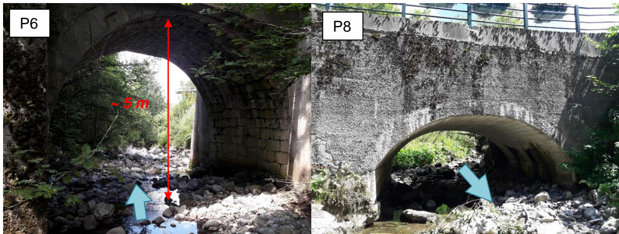
A gauche : pont au lieu-dit le Gotty (au niveau du profil PT06). A droite : pont au lieu-dit La Piclière (au niveau du profil PT08).
