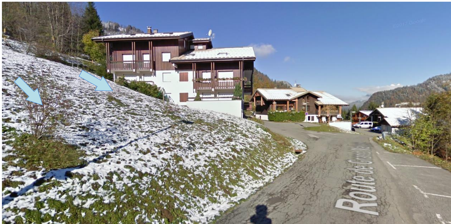
Habitations possiblement touchées par l'onde de crue 2 à l'extrémité de la route de Grand Maison (source : Google Street view)
