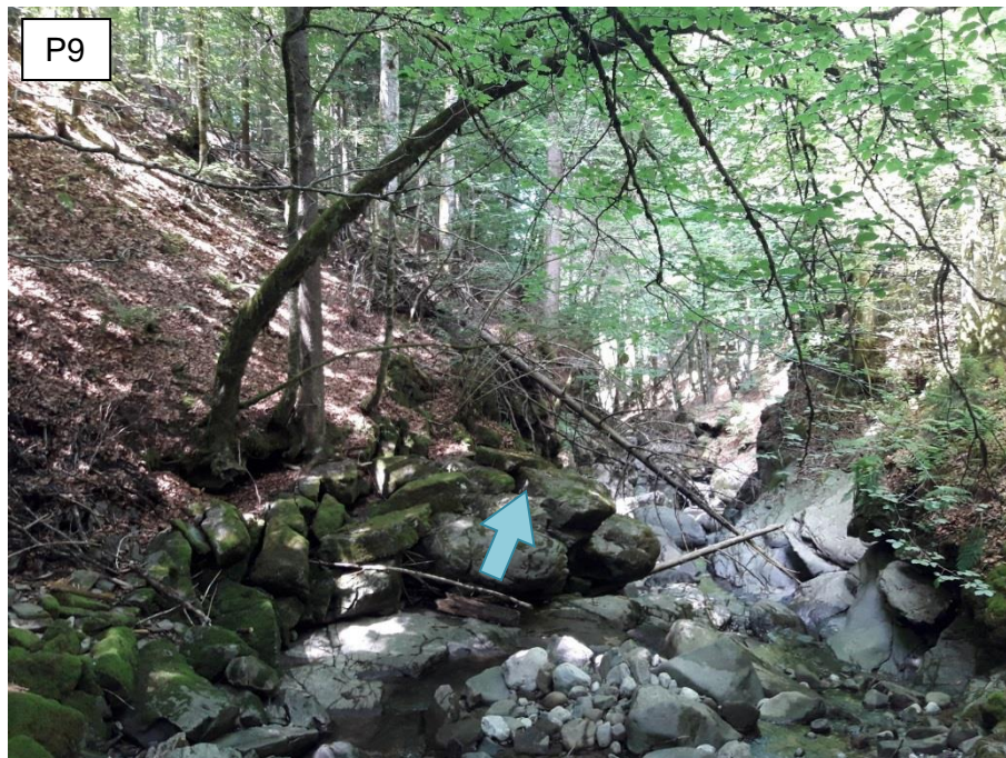
Le Nom, à l'aval du pont du lieu-dit la Piclière. Le lit devient beaucoup plus encaissé sur cette section.
