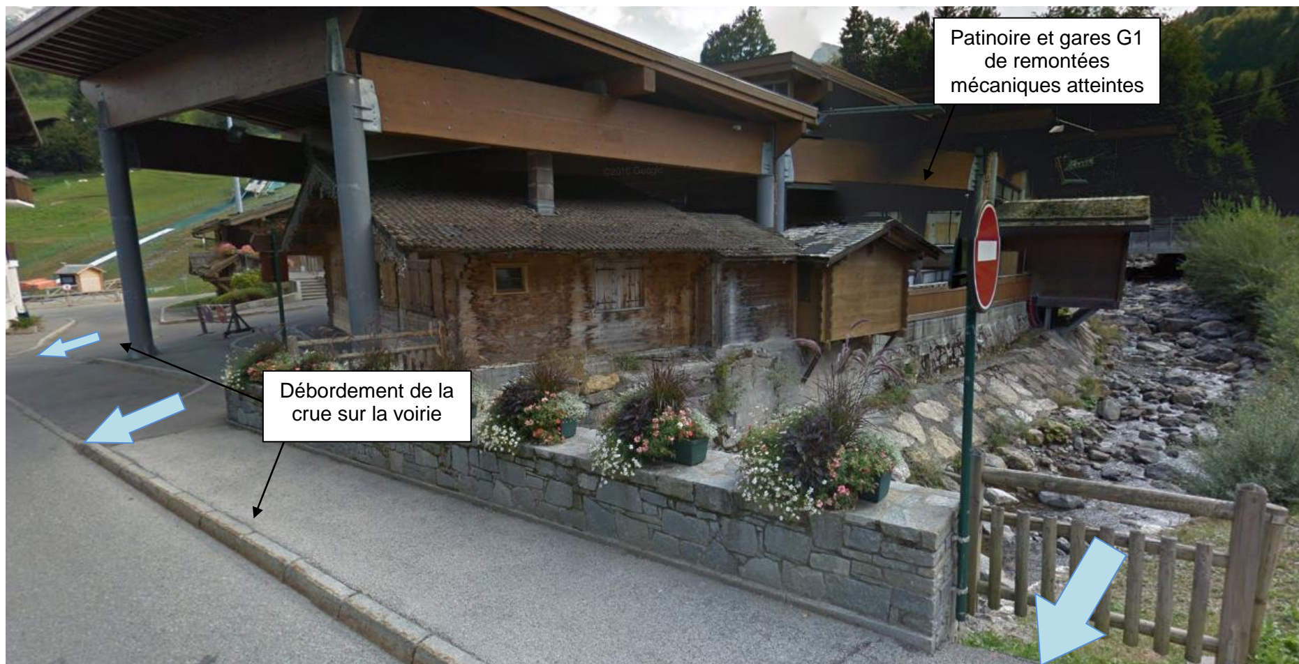
Pont à l'aval de la patinoire de la Clusaz - PT11 (source : Google Street view)
